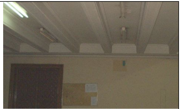
фиг.5. Фотография на контрафорсите (бетонните греди) на тавана на 4 етаж на сграда Б на Физическия факултет измерени с георадар (фиг.4)
